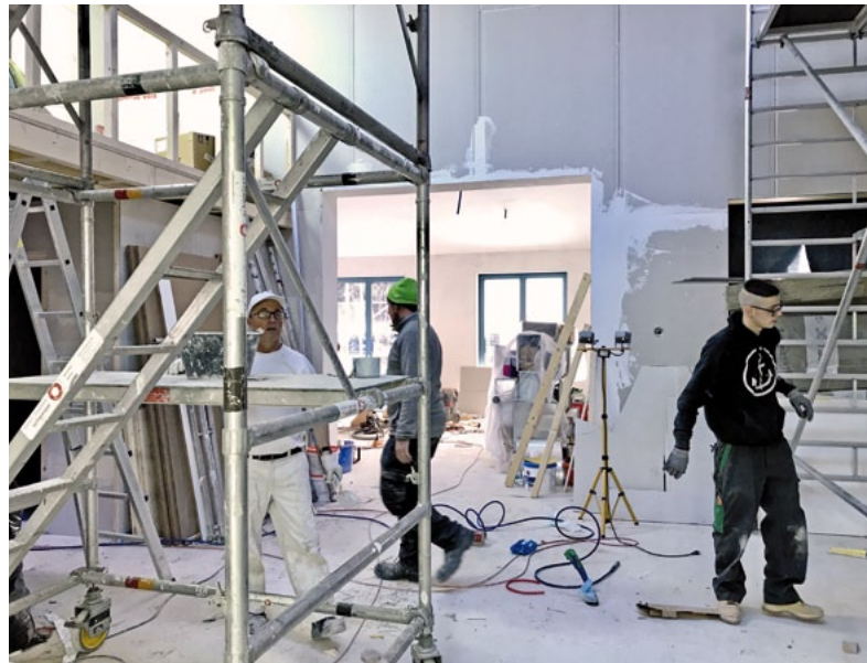
Der Innenausbau ist in vollem Gange
